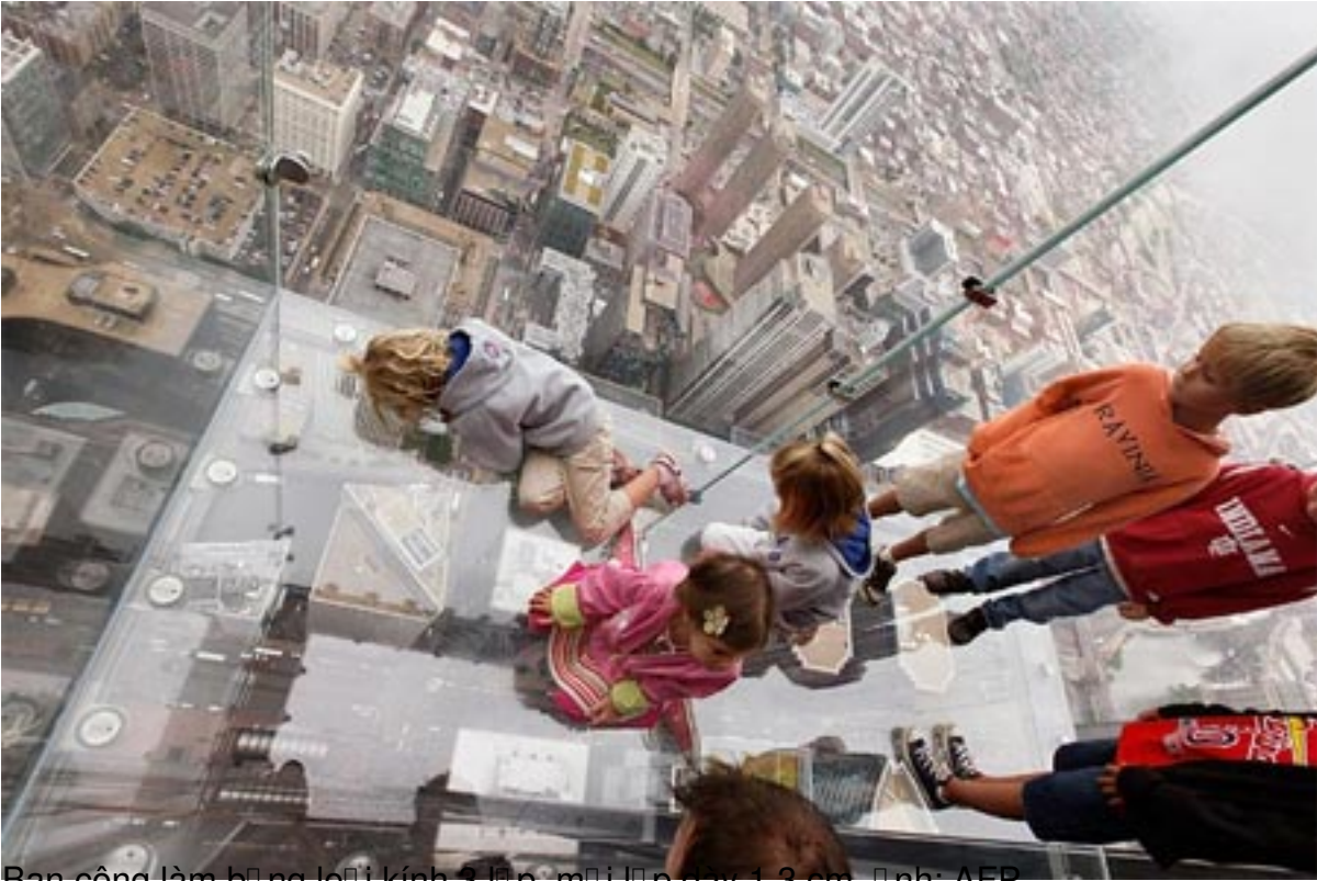
Ban công làm bằng kính 2 lớp mỗi lớp dày 1,2 cm. Ảnh: AFP
